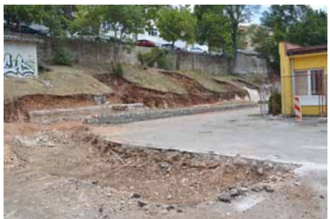
Mjesto izgradnje nove prometnice
