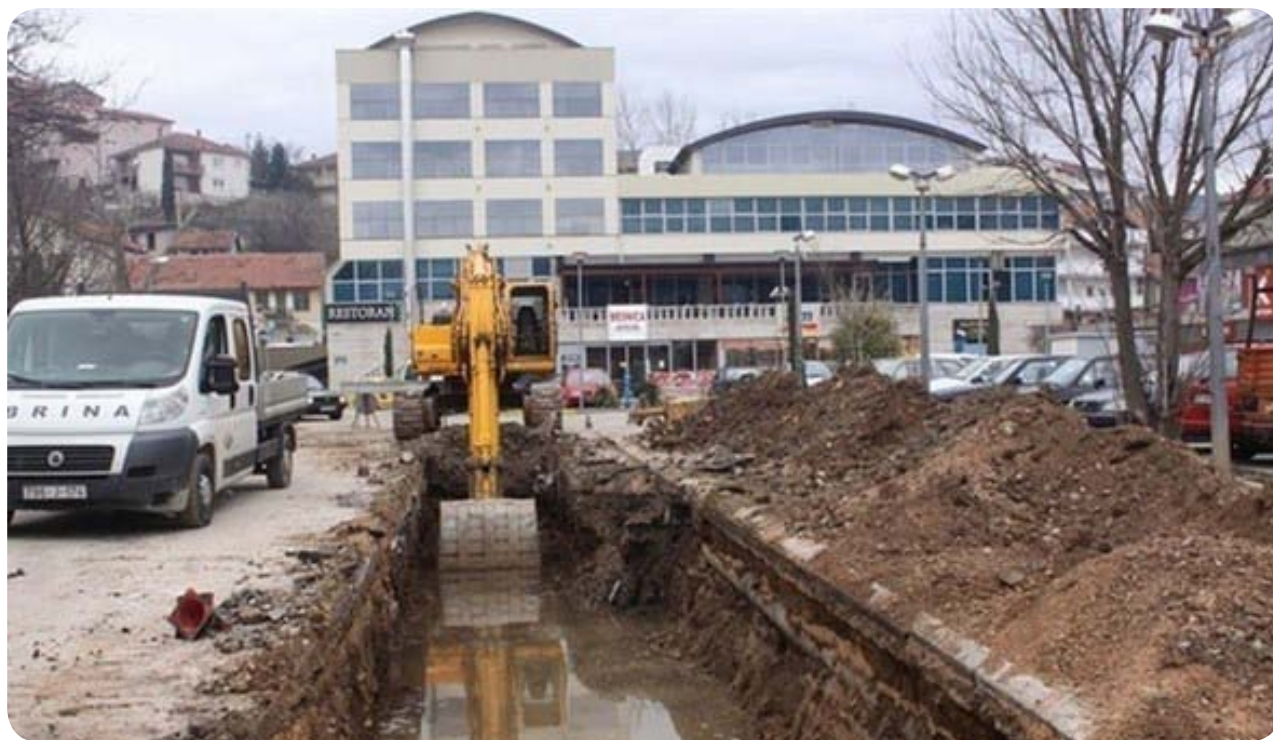
U tijeku radovi na izgradnji kanalizacije
